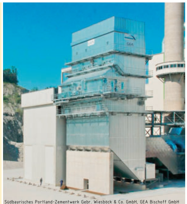
Südbayrisches Portland-Zementwerk Gebr. Wiesböck & Co. GmbH, GEA Bischoff GmbH
